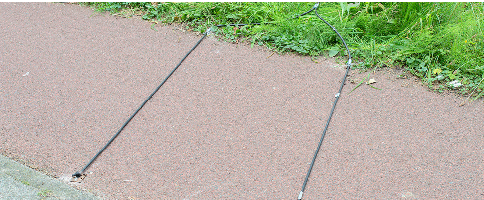
Voorbeeld van fietslussen over een fietspad, die het aantal fietsers meten in een gekaderd tijdsbestek.
