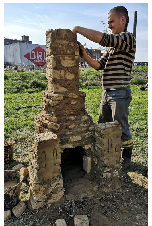
Voorbeeld van een kleine schachtoven
