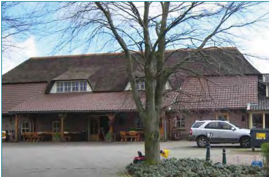
Rechtsboven: 'Deel' verbouwd tot slaapzaal voor 30 personen. Onder: gedeelte van de boerderij verbouwd tot restaurant
