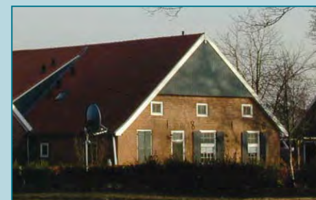
In het oosten van de Achterhoek: topgevels van hout met gaffelteken
