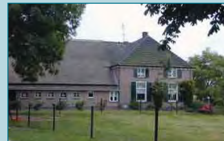
Scholtenboerderijen in het Oosten van de Achterhoek
