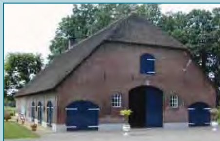
Riet als dakbedekking in het westen van de Achterhoek
