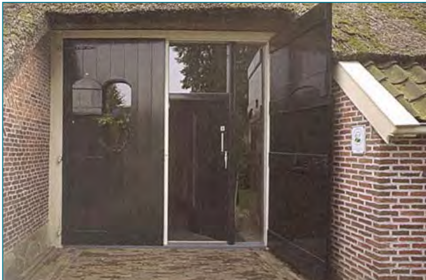
Verbouw van het oorspronkelijke hoofdgebouw
