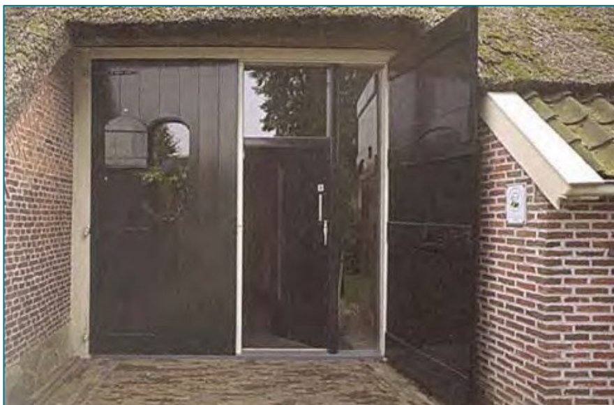
Verbouw van het oorspronkelijke hoofdgebouw
