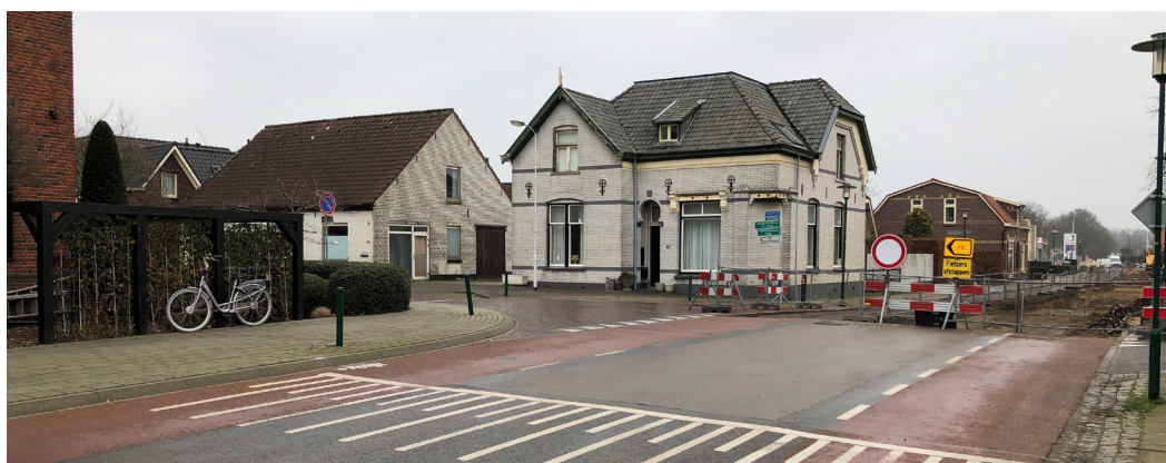
De reconstructie van de kruising op de Zeddamsesweg start eerder dan gepland, om de overlast zoveel mogelijk te beperken.
